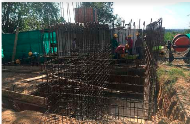
Construcción Planta de tratamiento
