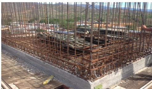
Construcción Planta de Tratamiento de Agua Potable.
